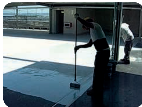
Nanášení podlahového nátěru weber.sys PUR-B ve dvou vrstvách.
