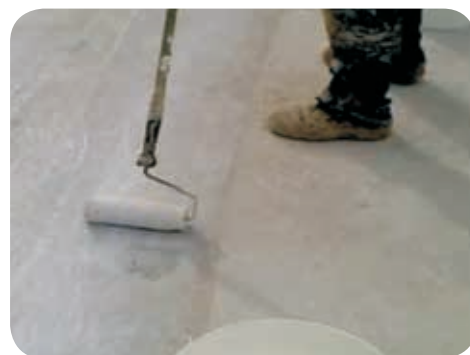
Nanášení penetračního nátěru weber.podklad PUR .
