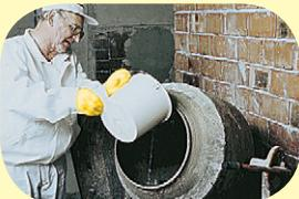
Do míchačky se nejdříve nadávuje čistá voda cca 4,6 l na jeden pytel (25 kg) a za stálého míchání se vsypává suchá směs. Hmota se míchá cca 5 minut. Případné dodatečné přidání vody provádime pomalu a opatrně tak, aby hmota na konci míchacího cyklu byla požadované konzistence. Aplikace se provádí ručním nanesením pokrývačskou lžící na střešní tašky nebo hřebenáče.
