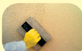
Následující den po aplikaci se provede vyškrábání povrchu speciálním škrábákom na tl. 8 mm.
