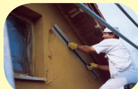
Omítka se ihned po nastříkání na zeď stahuje zubatým hladítkem. Velmi důležitá operace pro vytačení vzduchových bublin z omítky.
