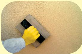
Následující den po aplikaci se provede vyškrábání povrchu speciálním škrábákem na tl. 8 mm.
