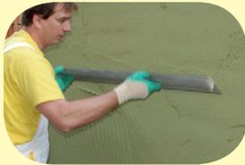
Omítka se ihned po nastříkání na zeď stahuje zubatým hladítkem. Velmi důležitá operace pro vytlačení vzduchových bublin z omítky.
