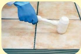
Po osazení dlaždice do lepidla poklepem plastovou paličkou stabilizujeme dlažbu a vytlačíme vzduch. Spárovací maltu aplikujeme po 24 hod.
