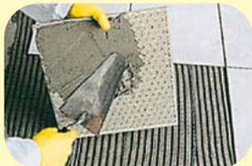
Doporučujeme lepit způsobem oboustranného lepení – tzn. na dlaždici se nanese vrstva lepidla 1–2 mm silná.
