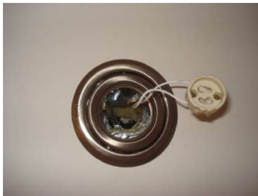
Poškození nevhodně umístěné parotěsné vrstvy při dodatečné montáži elektroinstalací
