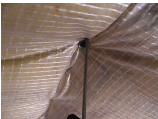
Perforace parozábrany kotevními prvky
